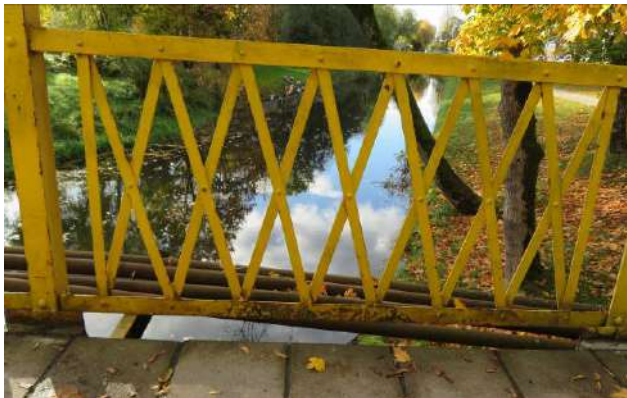
2.4 pav. Turėklų dažų danga nusidėvėjusi, koroduoja elementai
