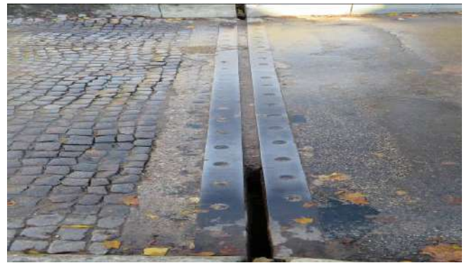
2.2 pav. I atramos pjūvis. Skylė tarp profilių, vanduo teka ant žemiau esančių konstrukcijų
