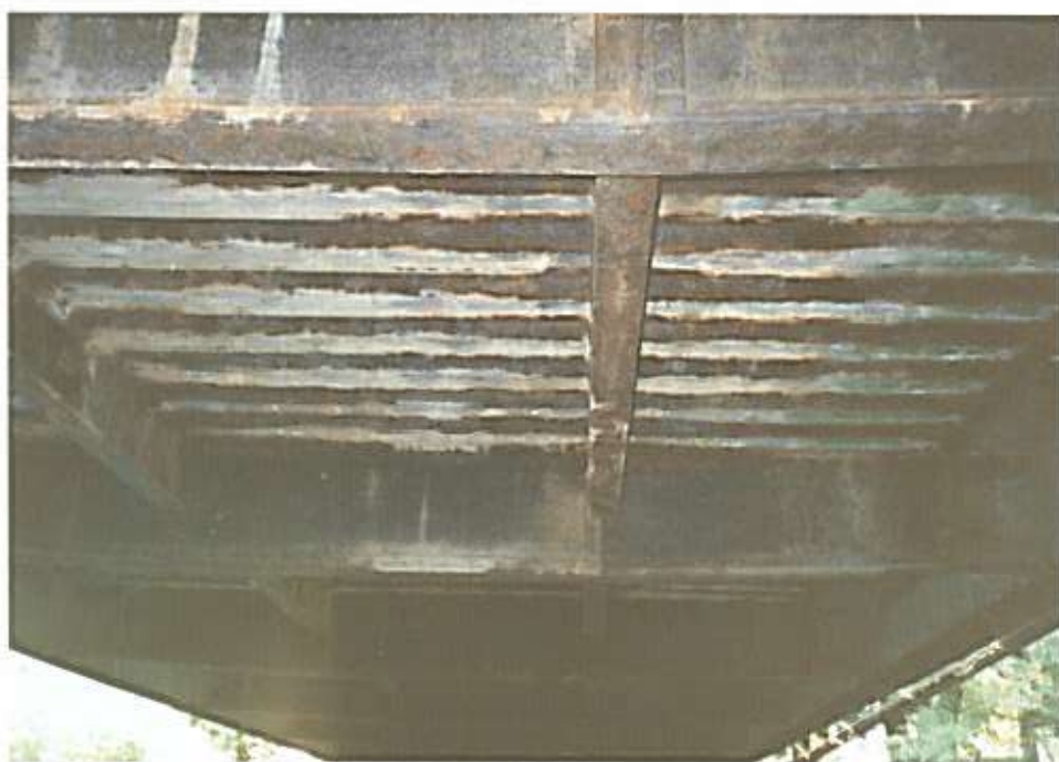
6 nuotr. Tilto važ. dalies konstrukcijų vaizdas iš apačios.
