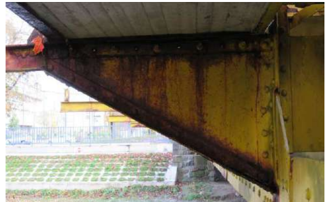
2.5 pav. Šaliteljius laikančios gembės labai pažeistos korozijos
