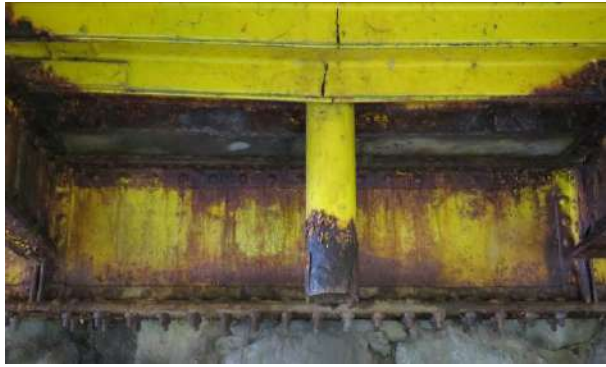
2.6 pav. Vandens nuleidimo šulinėliai koroduoja, iš jų tekantis vanduo drėkina ramtus
