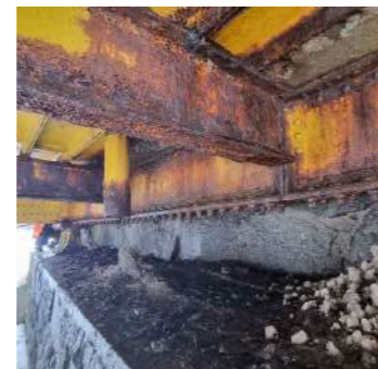
F17. išilginės ir kraštinės skersinės sijos būklės vaizdas
