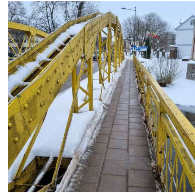
F2. esamas betoninių šaligatvio plytelių vaizdas
