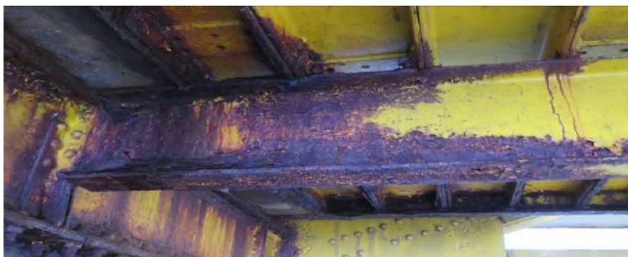
2.8 pav. Perdanga virš pirmos atramos, žymi metalo korozija
